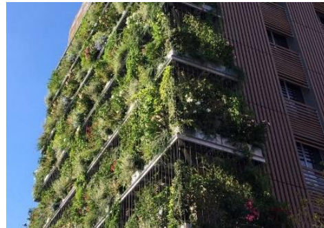
Facciata verde indiretta in combinazione con elementi contenitori di Hotel VIU a Milano
