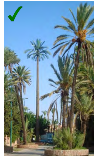
Fig. 51 - Design: non sempre il contesto consente una forte caratterizzazione degli impianti, ma richiede, invece, operazioni di mimetizzazione al fine di non alterare la struttura consolidata del paesaggio. I camuffamenti dovranno, tuttavia, configurarsi come nuovi elementi di qualità evitando, invece, falsi evidenti e fuori scala. Nel caso perciò della scelta di finti elementi arborei questi dovranno accordarsi per colore ed essenza a quelli propri del contesto. Nel caso dell'aggiunta di elementi architettonici ad edifici preesistenti essi dovranno riprendere forme e materiali dei relativi supporti. (foto: Wikipedia commons, calzavara.it, wired.it)
