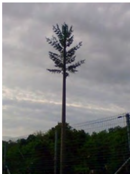
Fig. 38 - Design: l'esigenza di mimetizzare, soprattutto in ambiti extraurbani, gli impianti che necessitano di sostegni di grande altezza, porta talvolta ad adottare camuffamenti che, tuttavia, creano evidenti fratture nel contesto paesaggistico. Le immagini mostrano, ad esempio, tre casi in cui il camuffamento dell'antenna mediante l'adozione di un finto albero fuori scala ed estraneo alle specie preesistenti non contribuisce alla valorizzazione del contesto. (foto: Lionella Scazzosi, youreporter.it)
