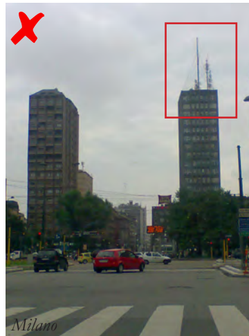
Fig. 35 - Criteri di posizionamento. La concentrazione delle installazioni in un unico sito ne riduce la proliferazione e disseminazione sul territorio, ma ne accresce certamente l'impatto visivo. Nel caso venga scelta la condivisione bisogna porre attenzione all'interferenza delle frequenze radio e alla portanza della torre. Infatti, qualora compaiano interferenze è necessario aumentare la potenza emissiva dell'antenna aumentando conseguentemente la sua dimensione e, dunque, il suo impatto visivo. La disposizione di diverse antenne in un unico luogo, impone un rigoroso ordine dell'installazione progettando a blocco unico tutti i dispositivi accessori. (foto: Raffaella Laviscio, Lionella Scazzosi)
