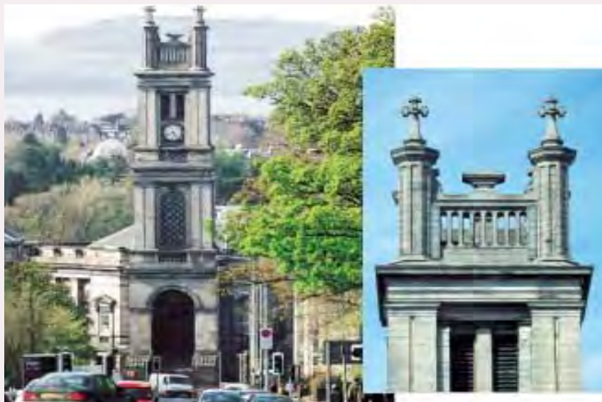
Fig. 74 - Installazioni su edifici di carattere storico: la chiesa di Santo Stefano ad Edimburgo ha otto antenne per la telefonia mobile installate dietro pannelli di fibra di vetro verniciati abbinati alla muratura sulla sommità della torre. Anche su edifici estremamente sensibili la cura della progettazione architettonica può garantire il consono inserimento di impianti tecnologici.
