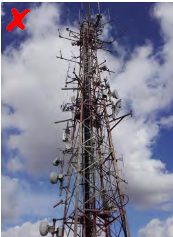
Fig. 35 - Criteri di posizionamento. La concentrazione delle installazioni in un unico sito ne riduce la proliferazione e disseminazione sul territorio, ma ne accresce certamente l'impatto visivo. Nel caso venga scelta la condivisione bisogna porre attenzione all'interferenza delle frequenze radio e alla portanza della torre. Infatti, qualora compaiano interferenze è necessario aumentare la potenza emissiva dell'antenna aumentando conseguentemente la sua dimensione e, dunque, il suo impatto visivo. La disposizione di diverse antenne in un unico luogo, impone un rigoroso ordine dell'installazione progettando a blocco unico tutti i dispositivi accessori. (foto: Raffaella Laviscio, Lionella Scazzosi)
