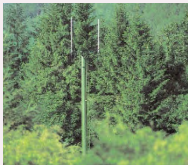
Fig. 79 - La colorazione dei montanti: in ambito rurale e montano può essere utile la collocazione delle strutture all'interno di gruppi di alberi adottando la colorazione verde.
