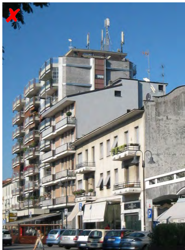
Fig. 48 - Criteri di posizionamento: spesso la condivisione dello stesso luogo di installazione non si accompagna alla condivisione della struttura di supporto. Il posizionamento casuale di supporti e celle genera un effetto di disordine. Più opportunamente le celle di telefonia mobile dovrebbero essere posizionate in modo accorpato dando l'idea di costituire un corpo unico. Si dovrebbe inoltre minimizzare il più possibile la visibilità di strutture di supporto e accessori. (foto: Raffaella Laviscio, Lionella Scazzosi)
