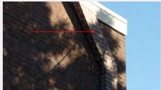
Fig. 86 - Alloggiamento dei cavi: i cavi devono sempre essere alloggiati all'interno delle strutture. Laddove la costruzione esistente non lo consenta, è necessario prevedere aggiunte la cui dimensione sia la minima necessaria al passaggio dei cavi. Le aggiunte riprenderanno materiali, colori e finiture proprie della struttura preesistente. Nelle immagini il passaggio dei cavi è realizzato all'interno di un'estensione dell'architettura realizzata in forme consone all'edificio preesistente.
