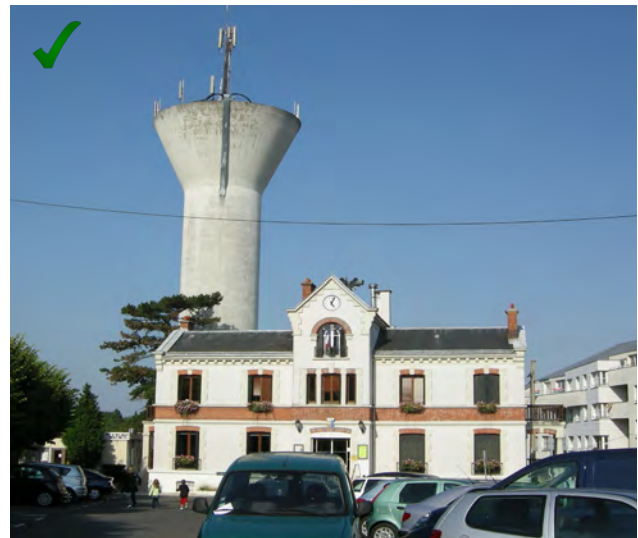
Fig. 47 - Criteri di posizionamento: le torri dell'acqua rappresentano luogo privilegiato per l'installazione di antenne per la telefonia mobile. Il posizionamento degli elementi avviene generalmente intorno al coronamento o nella parte centrale; dovrà essere, comunque, tale da garantire un effetto di ordine e la maggiore integrazione possibile con il manufatto. Nel caso di aggiunta di nuove antenne in luoghi in cui ne siano già presenti è opportuno che forme e colori si rifacciano a quelli degli elementi preesistenti. (foto: Lionella Scazzosi)
