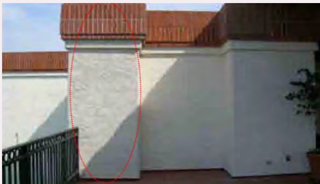
Fig. 86 - Alloggiamento dei cavi: i cavi devono sempre essere alloggiati all'interno delle strutture. Laddove la costruzione esistente non lo consenta, è necessario prevedere aggiunte la cui dimensione sia la minima necessaria al passaggio dei cavi. Le aggiunte riprenderanno materiali, colori e finiture proprie della struttura preesistente. Nelle immagini il passaggio dei cavi è realizzato all'interno di un'estensione dell'architettura realizzata in forme consone all'edificio preesistente.
