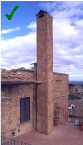
Fig. 51 - Design: non sempre il contesto consente una forte caratterizzazione degli impianti, ma richiede, invece, operazioni di mimetizzazione al fine di non alterare la struttura consolidata del paesaggio. I camuffamenti dovranno, tuttavia, configurarsi come nuovi elementi di qualità evitando, invece, falsi evidenti e fuori scala. Nel caso perciò della scelta di finti elementi arborei questi dovranno accordarsi per colore ed essenza a quelli propri del contesto. Nel caso dell'aggiunta di elementi architettonici ad edifici preesistenti essi dovranno riprendere forme e materiali dei relativi supporti. (foto: Wikipedia commons, calzavara.it, wired.it)
