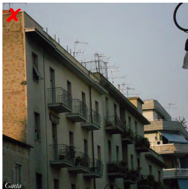
Fig. 45 - Criteri di posizionamento: al fine di evitare la proliferazione di parabole e antenne su edifici con più utenze è bene perseguire la centralizzazione degli impianti. Esso consente un minore inquinamento visivo, un minor danneggiamento degli elementi edilizi dell'edificio (siano essi facciate che coperture) e contemporaneamente una migliore ricezione dei segnali TV garantendo a tutti gli utenti un segnale più forte ed esente da disturbi e interferenze. Tali indicazioni diventano prioritarie nei centri caratterizzati da una forte unitarietà materica e formale al fine di non introdurre elementi di rottura; sono, comunque, criteri di valorizzazione anche dei luoghi che non hanno una specifica caratterizzazione. (foto: Lionella Scazzosi, Raffaella Laviscio)
