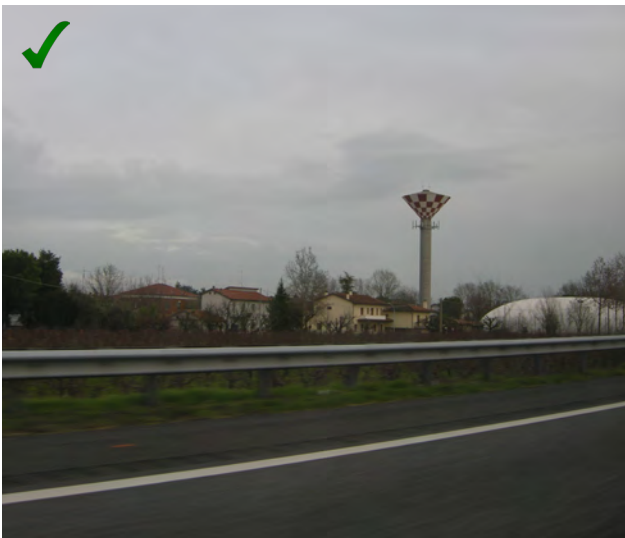
Fig. 47 - Criteri di posizionamento: le torri dell'acqua rappresentano luogo privilegiato per l'installazione di antenne per la telefonia mobile. Il posizionamento degli elementi avviene generalmente intorno al coronamento o nella parte centrale; dovrà essere, comunque, tale da garantire un effetto di ordine e la maggiore integrazione possibile con il manufatto. Nel caso di aggiunta di nuove antenne in luoghi in cui ne siano già presenti è opportuno che forme e colori si rifacciano a quelli degli elementi preesistenti. (foto: Lionella Scazzosi)
