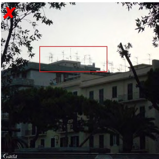
Fig. 45 - Criteri di posizionamento: al fine di evitare la proliferazione di parabole e antenne su edifici con più utenze è bene perseguire la centralizzazione degli impianti. Esso consente un minore inquinamento visivo, un minor danneggiamento degli elementi edilizi dell'edificio (siano essi facciate che coperture) e contemporaneamente una migliore ricezione dei segnali TV garantendo a tutti gli utenti un segnale più forte ed esente da disturbi e interferenze. Tali indicazioni diventano prioritarie nei centri caratterizzati da una forte unitarietà materica e formale al fine di non introdurre elementi di rottura; sono, comunque, criteri di valorizzazione anche dei luoghi che non hanno una specifica caratterizzazione. (foto: Lionella Scazzosi, Raffaella Laviscio)
