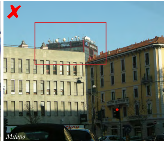
Fig. 35 - Criteri di posizionamento. La concentrazione delle installazioni in un unico sito ne riduce la proliferazione e disseminazione sul territorio, ma ne accresce certamente l'impatto visivo. Nel caso venga scelta la condivisione bisogna porre attenzione all'interferenza delle frequenze radio e alla portanza della torre. Infatti, qualora compaiano interferenze è necessario aumentare la potenza emissiva dell'antenna aumentando conseguentemente la sua dimensione e, dunque, il suo impatto visivo. La disposizione di diverse antenne in un unico luogo, impone un rigoroso ordine dell'installazione progettando a blocco unico tutti i dispositivi accessori. (foto: Raffaella Laviscio, Lionella Scazzosi)
