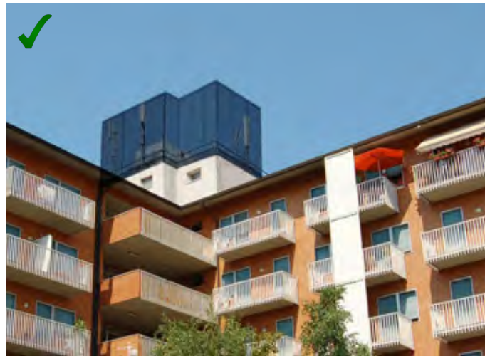
Fig. 51 - Design: non sempre il contesto consente una forte caratterizzazione degli impianti, ma richiede, invece, operazioni di mimetizzazione al fine di non alterare la struttura consolidata del paesaggio. I camuffamenti dovranno, tuttavia, configurarsi come nuovi elementi di qualità evitando, invece, falsi evidenti e fuori scala. Nel caso perciò della scelta di finti elementi arborei questi dovranno accordarsi per colore ed essenza a quelli propri del contesto. Nel caso dell'aggiunta di elementi architettonici ad edifici preesistenti essi dovranno riprendere forme e materiali dei relativi supporti. (foto: Wikipedia commons, calzavara.it, wired.it)
