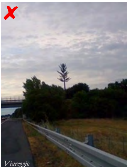
Fig. 38 - Design: l'esigenza di mimetizzare, soprattutto in ambiti extraurbani, gli impianti che necessitano di sostegni di grande altezza, porta talvolta ad adottare camuffamenti che, tuttavia, creano evidenti fratture nel contesto paesaggistico. Le immagini mostrano, ad esempio, tre casi in cui il camuffamento dell'antenna mediante l'adozione di un finto albero fuori scala ed estraneo alle specie preesistenti non contribuisce alla valorizzazione del contesto. (foto: Lionella Scazzosi, youreporter.it)
