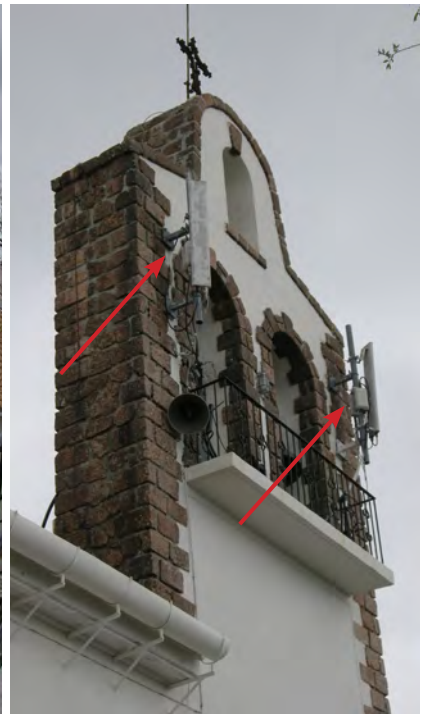
Fig. 44 - Criteri di localizzazione: la collocazione su edifici storici, vincolati o di particolare rilevanza per la percezione sociale va, generalmente, evitata a meno di una totale integrazione con il manufatto, grazie all'uso di tecnologie innovative che ne garantiscano la non visibilità. In ogni caso vanno minimizzati il più possibile tutti gli elementi accessori e adottato un generale criterio di ordine. (foto: Lionella Scazzosi)
