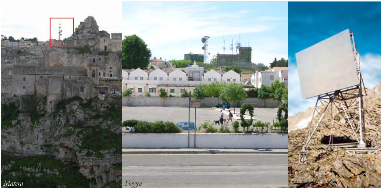
Fig. 3 - Tipi di impianto e paesaggio: i grandi impianti per le radio telecomunicazioni (che comprendono stazioni radio base, ponti radio, ripetitori passivi) pongono, innanzitutto, problematiche relative alle loro dimensioni e alla scelta dell'ideale localizzazione. (foto: Lionella Scazzosi, calzavara.it)
