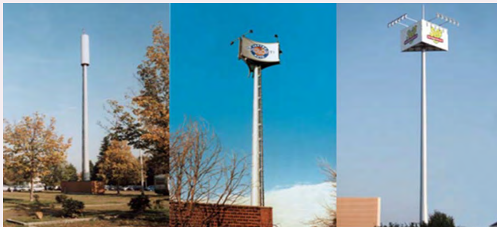
Fig. 55 - Design: è opportuno prediligere la sincerità espressiva, che deve essere messa in evidenza; pertanto a tecnologia moderna devono corrispondere, di massima, materiali moderni. Non è possibile tuttavia l'esclusione a priori di invenzioni che inseriscano forme e materiali tradizionali a mitigazione della presenza di manufatti tecnologici.
