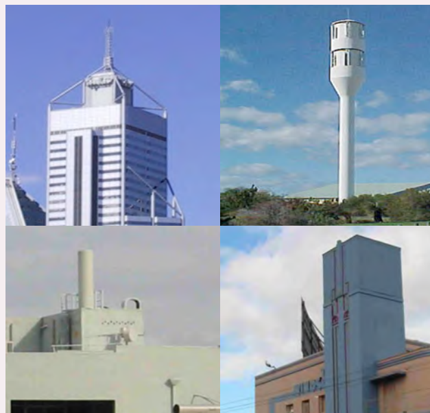
Fig. 89 - Integrazione: integrare un'antenna per le telecomunicazioni ad un edificio o una struttura esistente non significa semplicemente giustapporre gli elementi, ma progettare i nuovi impianti in modo che i configurino come parte integrante del supporto che utilizzano. Diversi sono gli espedienti utilizzabili: 1. Adeguamento alle dimensioni complessive (altezza e scala) della struttura; 2. Abbinamento del colore a quello delle pareti di supporto; 3. Creazione di un elemento architettonico apposito, come una guglia, una colonna, una ciminiera; 4. Estensione di un elemento di facciata.
