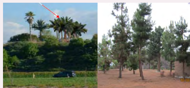
Fig. 84 - Camuffamento mediante uso di finta vegetazione: la scelta deve essere effettuata secondo tipologie arboree diffuse nell'area di installazione. I falsi alberi devono essere posizionati all'interno o vicino ad un gruppo di alberi naturali e la dimensione deve essere adeguata a quella degli alberi esistenti per non creare un effetto di fuori scala. Qualora si scelga di installare le antenne su alberature esistenti è opportuno disporle in maniera tale che non siano visibili tenendo conto delle variazioni stagionali della chioma.
