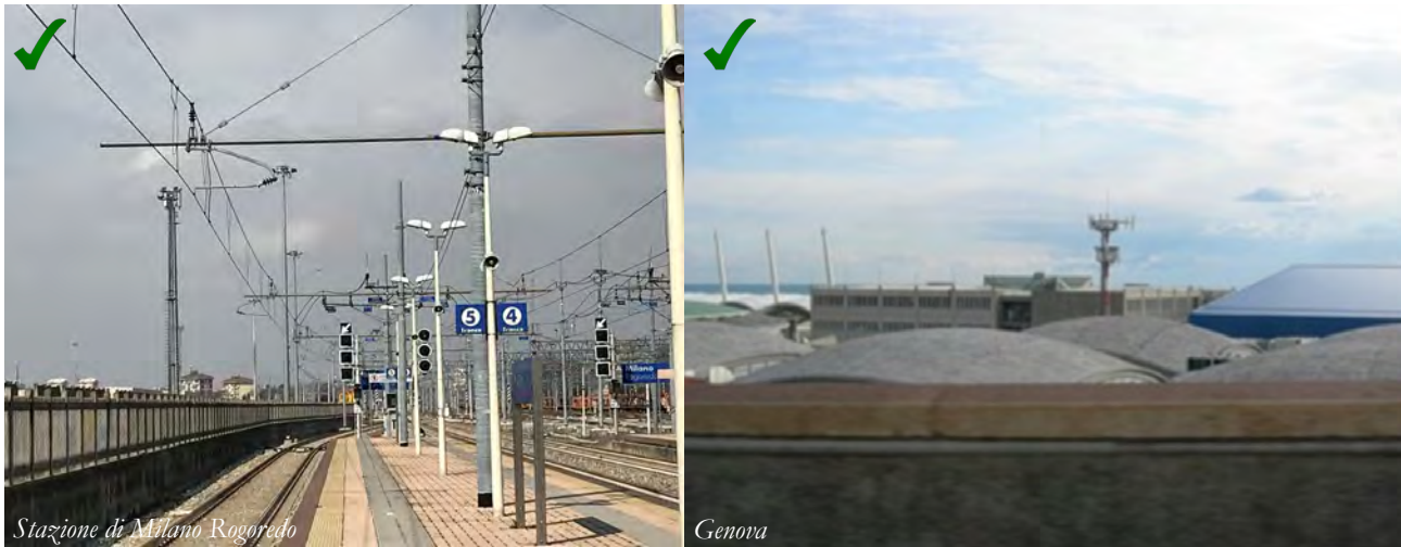
Fig. 31 - Scelta del luogo di installazione: i grandi impianti per le telecomunicazioni possono trovare collocazione adeguata lungo le infrastrutture stradali, le linee ferroviarie e le linee elettriche già esistenti con soluzioni integrate che aiutino l'osservatore a percepire il canale tecnologico dovuto alla presenza di infrastrutture a rete come unità. Anche gli ambienti industriali, caratterizzati dalla presenza di edifici di grossa taglia e disposti su grandi superfici, possono rappresentare un contesto consono all'installazione di impianti per le telecomunicazioni che rappresentano, in questo caso, un elemento tecnologico congruente con le destinazioni d'uso già in essere. (foto: Raffaella Laviscio)
