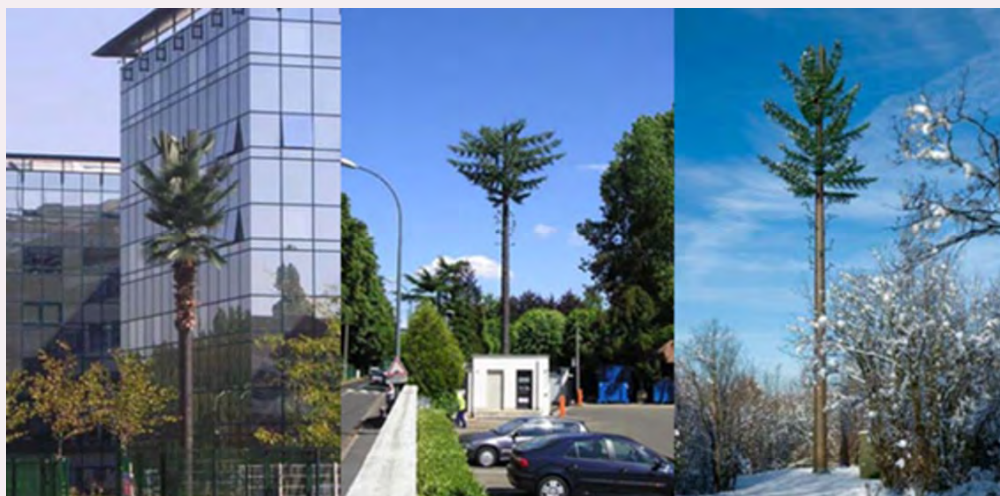
Fig. 57 - Il camuffamento delle antenne mediante l'uso della vegetazione: le linee guida sottolineano la necessità, nell'uso di espedienti per il camuffamento degli impianti mediante l'uso della vegetazione, di prestare grande attenzione ai rapporti di scala e alla scelta di specie consone al contesto.
