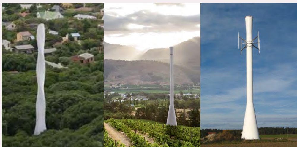
Fig. 56 - Design: le linee guida suggeriscono per alcune specifiche situazioni una qualificazione di tali oggetti come "monumenti" ordinatori del paesaggio. Elementi di design non necessariamente mimetici bensì di forte impatto, possono costituire presenze riconoscibili che definiscono un disegno sul territorio. Colore e finiture saranno valutati al fine di una corretta integrazione con il paesaggio e i suoi colori.
