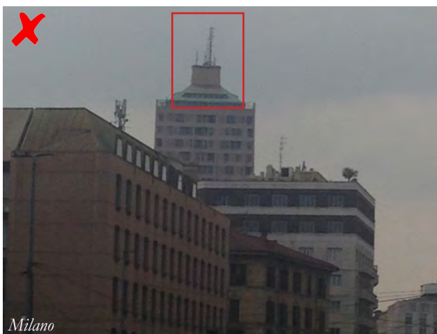
Fig. 42 - Criteri di localizzazione: la collocazione su edifici storici, vincolati o di particolare rilevanza per la percezione sociale pone interrogativi circa l'opportunità di tale scelta. L'immagine mostra la Torre Velasca di Milano, edificio progettato dallo studio BBPR negli anni Cinquanta in stretto rapporto col contesto in cui sorge, in particolar modo col Duomo, i campanili della città, ma soprattutto col Castello Sforzesco. Il profilo della torre è la conseguenza di un approfondito studio che, partendo dall'esiguo spazio di cui dispone alla base, trova modalità di ampliarsi ai piani superiori. Le linee architettoniche verticali rischiano di non trovare continuità e di essere disordinate dalla moltiplicazione di installazioni di antenne di diversi gestori telefonici poste sulla sommità dell'edificio. (foto: Raffaella Laviscio)
