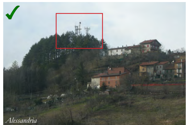
Fig. 28 - Scelta del luogo di installazione: nella scelta del luogo di installazione è bene evitare le creste dei crinali soprattutto laddove esse siano ampiamente visibili dai centri abitati e dalle grandi vie di comunicazione, nonché da luoghi di particolare valenza storico-artistica e frequentazione. Quando esigenze tecniche non consentano diversamente andrà contenuta il più possibile l'altezza dei tralicci di sostegno avendo peraltro accortezza di sfruttare sostegni eventualmente già esistenti ed evitando pertanto la moltiplicazione e concentrazione di più strutture. In ogni caso la predominanza visiva di elementi svettanti sulle creste montuose e collinari introduce nuovi punti di fuga che è bene non entrino in competizione con quelli eventualmente già propri del paesaggio consolidato. La presenza di vegetazione può essere sfruttata come elemento di mitigazione degli impatti visivi. (foto: Raffaella Laviscio, Lionella Scazzosi, Wikipedia Commons, latinacorriere.it)
